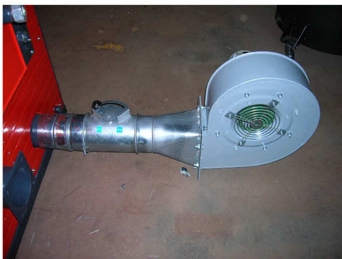
Raccordement conduit air primaire
