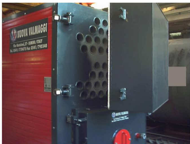
Portillon de nettoyage échangeur
