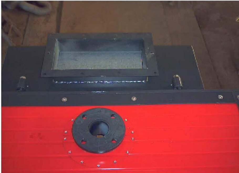
Raccordement conduit de décharge fumées
